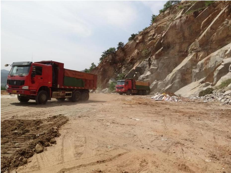
**图 4-8 采石坑渣土回填**
