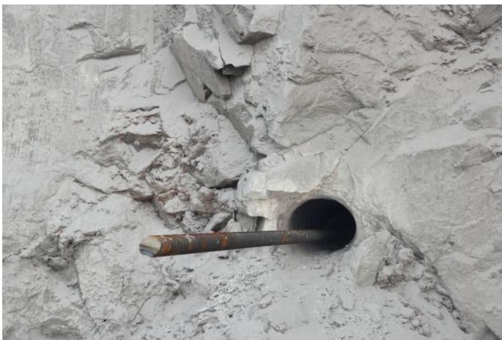
图 4-4 锚杆施工
